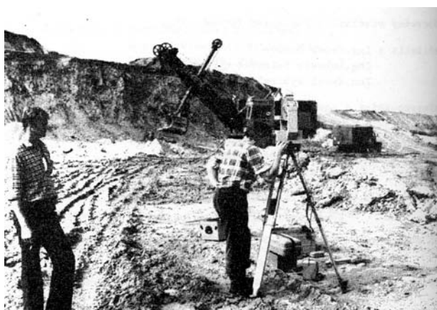
Obr. 8 Fotogrametrické meranie skrývky a výsypky v povrchovom hnedouhoľnom lome Lehota
